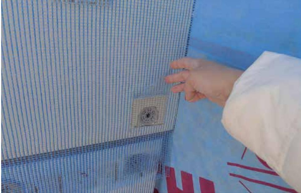
*Placa termoaislante Poliestireno Expandido revestida prefabricada para EIFS*
