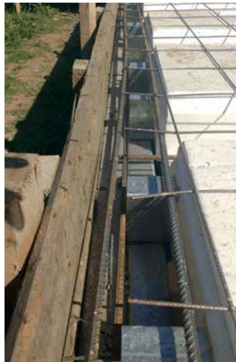
Una vez apoyada la tira sobre la estructura portante y previo a la circulación de los operarios, se debe afirmar sobre el terreno. Este procedimiento se debe ejecutar en líneas separadas cada 1,50 m entre sí. Terminado este proceso, el sistema se encuentra en condiciones de que los operarios pasen a la siguiente etapa de forma segura.
