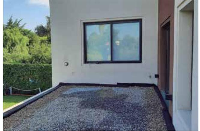
*De izquierda a derecha. 1. Colocación de placas sobre la impermeabilización hidrófuga (simplemente apoyadas). 2. Colocación del geotextil sobre las placas de Poliestireno Expandido. 3 y 4. Colocación de piedra sobre el geotextil.*
