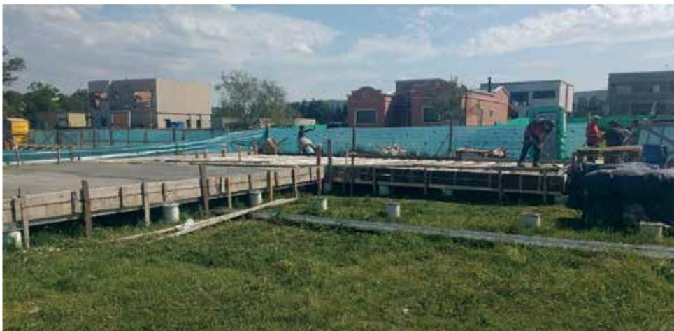
El tipo de hormigo dependerá del cálculo y la resistencia que requiera la losa. En lo posible se recomienda la utilización de piedra 6/12 y vibrado con el fin de evitar oquedades en los nervios. Para piedras de mayor tamaño se deberá tener en cuenta esta situación.
