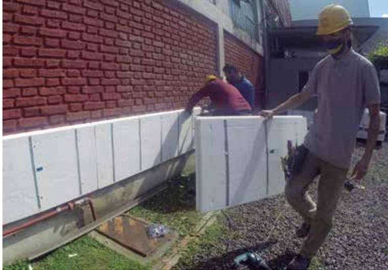
*Placa termo aislante de Poliestireno Expandido con perfiles incorporados para la fijación de revestimientos*
