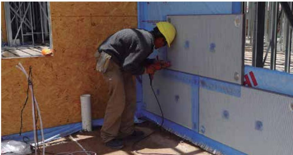
*Placa termoaislante Poliestireno Expandido revestida prefabricada para EIFS*
